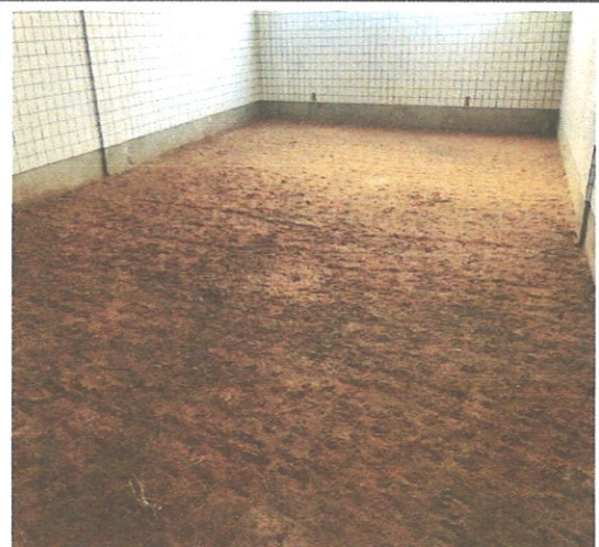
FOTO 100: Aterro e compactação do piso
