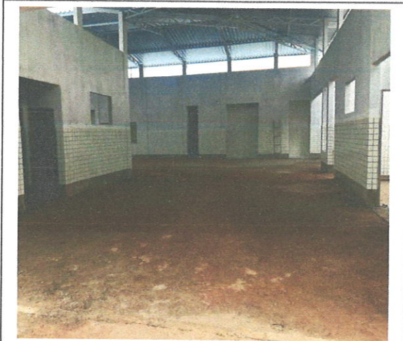
FOTO 101: Aterro e compactação do piso
