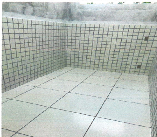
FOTO109: Assentamento revestimento cerâmico
