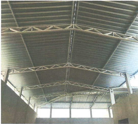
FOTO 97: Instalação das telhas sanduiches
