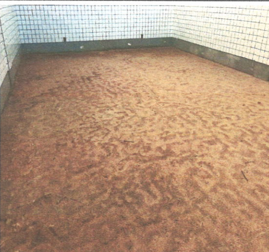
FOTO 99: Aterro e compactação do piso
