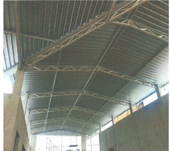
FOTO 98: Instalação das telhas sanduiches
