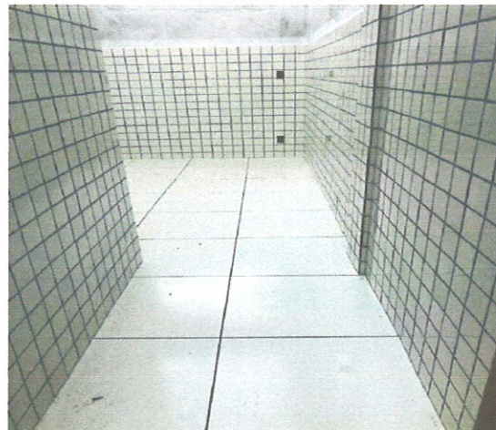
FOTO 110: Assentamento revestimento cerâmico
